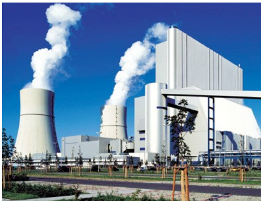
Quelle: Vattenfall Kraftwerk Schwarze Pumpe
