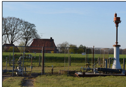
„Ausbläser“ zum Ableiten eindringender Gase an undichter Ölbohrung im Feld Voigtei
